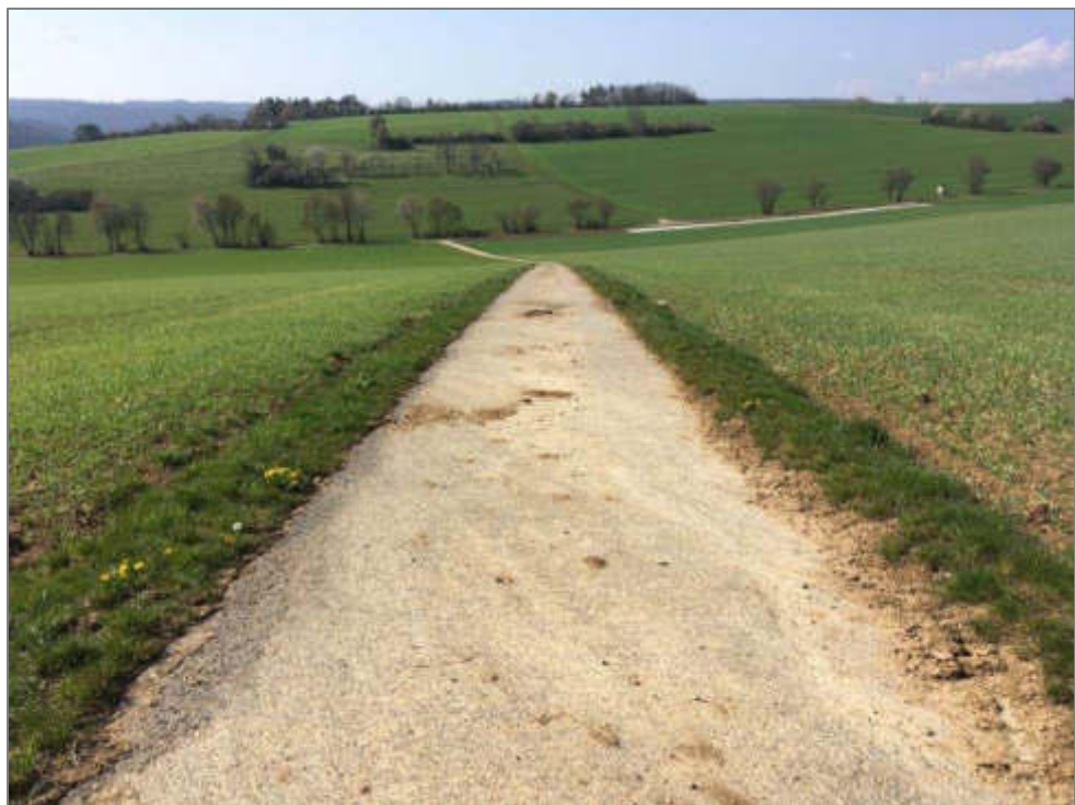
Abbildung 9: Durch das Plangebiet verlaufender, asphaltierter Wirtschaftsweg (Foto: HPC AG, 21.04.2021, Blick nach Süden)
